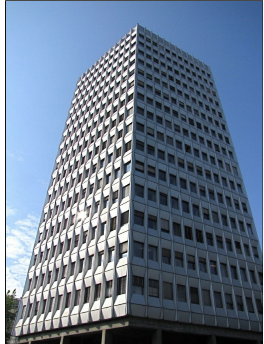
Le deuxième bâtiment pentagonal de l'UIT 57 mètres de haut, 15 étages ( André Bordigoni ). 1 ère pierre en 1970
