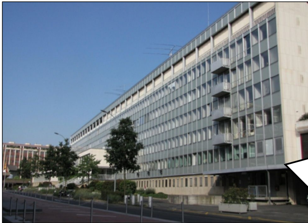
Le premier bâtiment de l'UIT inauguré en 1962 120 mètres sur 5 étages (dû à l'architecte Genevois André Bordigoni )
