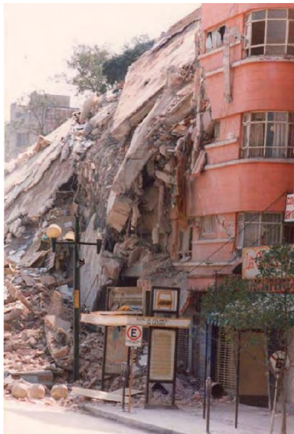
Figura 1.9 Colapso de edificios en la ciudad de México, sismo del 19 de septiembre de 1985
