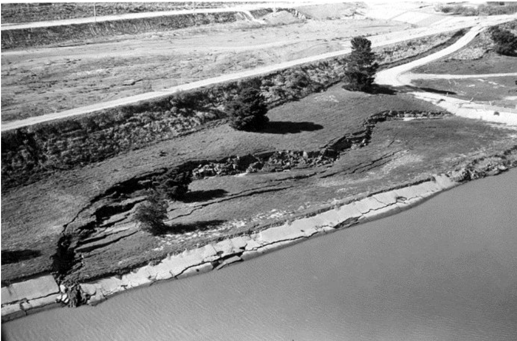
Figura 1.25 Deslizamiento en el almacenamiento Lower Van Norman (Fuente: U.S Geological Survey Photographic Library)
