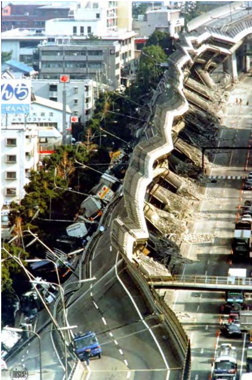
Figura 1.2 Colapso de la autopista Hanshin, en Kobe, Japón, durante el sismo del 17 de enero de 1995, M = 6.69 (Fotografía de la Kobe Collection NISEE, University of California, Berkeley)
