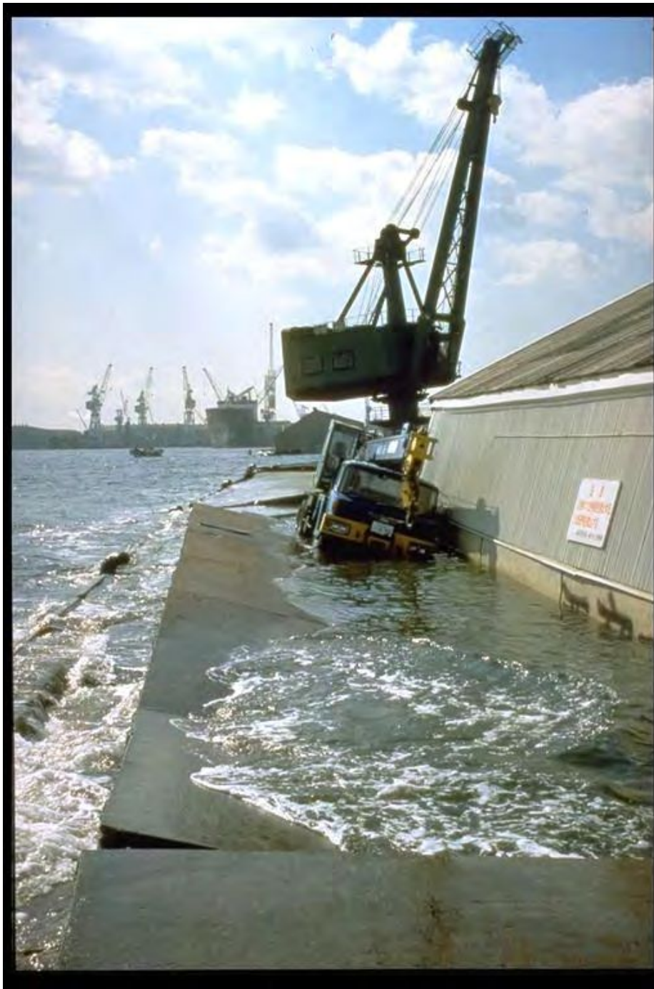
Figura 1.28 Colapso de una grúa debido a movimientos de 2 m de las estructuras de retención durante el sismo de Kobe del 17 de enero de 1995 ( Fotografía de la Kobe Geotechnical Collection, EERC, University of California, Berkeley)
