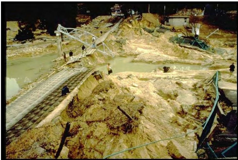
Figura 1.27 Falla de la cresta de la Presa Niteko, Kobe, Japón, durante el sismo del 17 de enero de 1995, M = 6.69 (Fotografía de la Kobe Geotechnical Collection NISEE, University of California, Berkeley)
