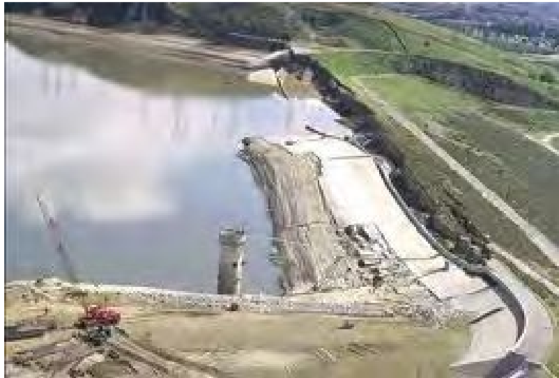
Figura 1.22 Daños causados al almacenamiento Lower Van Norman (Fotografía de la Steinbrugge Collection NISEE, University of California, Berkeley)
