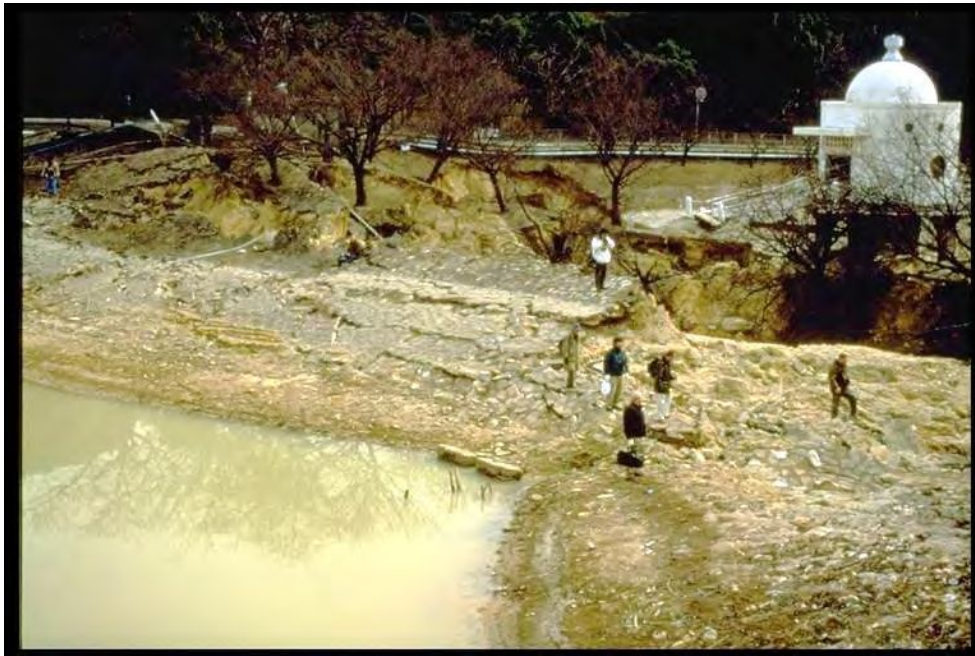
Figura 1.26 Falla del talud de aguas arriba de la Presa Niteko, Kobe Japón durante el sismo del 17 de enero de 1995, M = 6.69 (Fotografía de la Kobe Geotechnical Collection NISEE, University of California, Berkeley)
