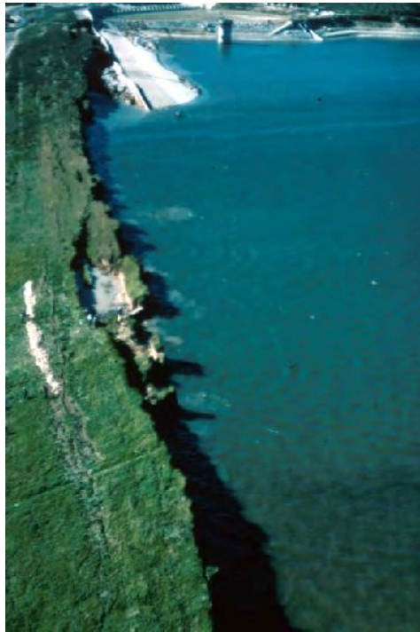
Figura 1.24 Deslizamiento en el almacenamiento Lower Van Norman (Fuente: U.S Geological Survey Photographic Library)
