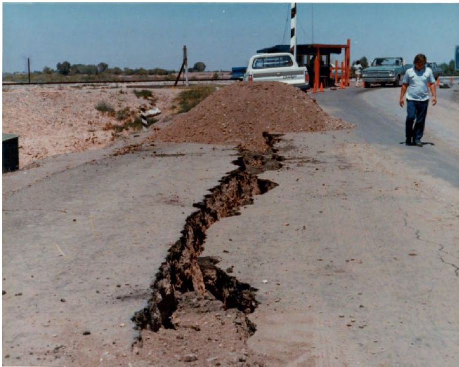
Figura 1.18 Grietas en el terreno debido a licuación, en el distrito de riego No. 14, Mexicali, Baja California, durante el sismo del 15 de octubre de 1979 ( M = 6.4 )
