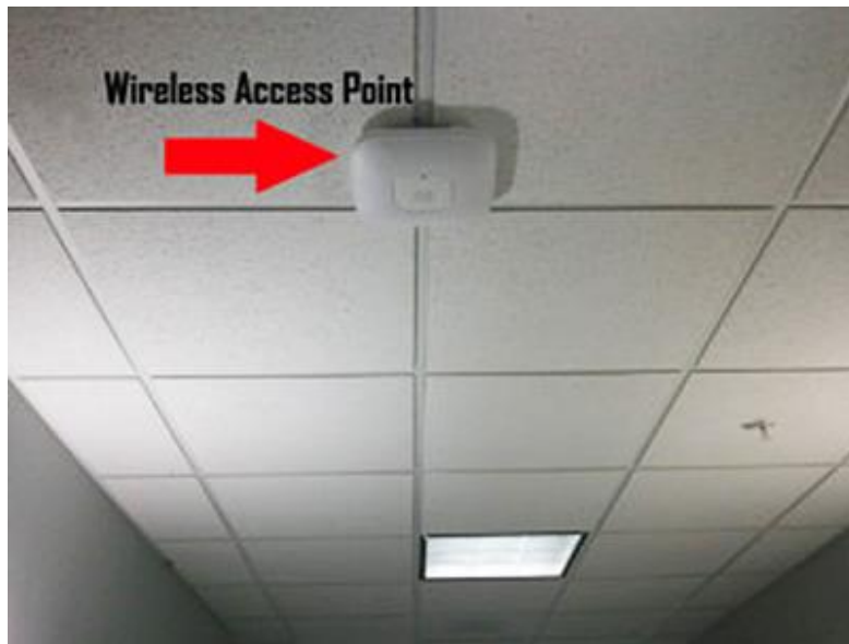
Tavana monte edilmiş bir Access Point (AP) cihazı
