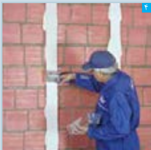
۴ اجرای لایه فوگن فولر بر روی کرم‌ها با استفاده از ماله دنداندار
