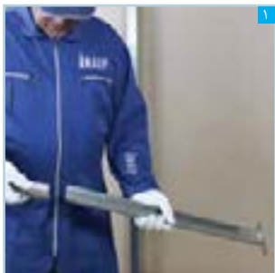
قطعه اتصال SC47 به صورت کشویی در سازه F47 قرار می‌گیرد.
