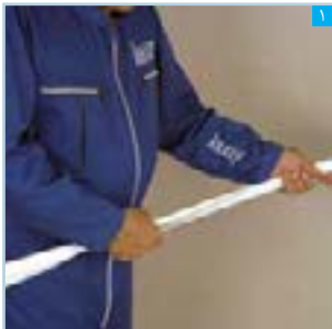
۱ خم کردن نوار درزگیر با دست
