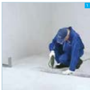
نصب رانر کف
