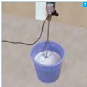
۵ رها کردن خمیر به مدت ۲ تا ۳ دقیقه
