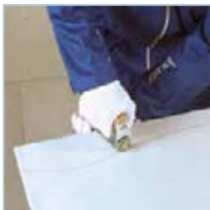
اجرای برش موج با دستگاه برش قرقره‌ای
