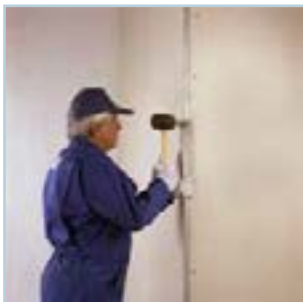
نصب سازه محافظ گوشه، با دستگاه کرنربید کوب
