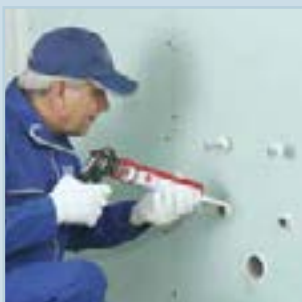
اجرای خمیر درزبند در اطراف خروجی‌های تاسیساتی
