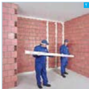
۲ چانه‌های پرفلیکس در فواصل حداکثر ۳۵ سانتیمتر (مرکز به مرکز) بر پشت کرم‌ها قرار می‌گیرند
