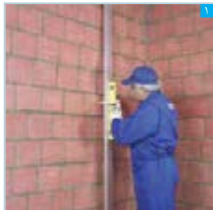
۱ اندازه‌گیری میزان ناهمواری دیوار
