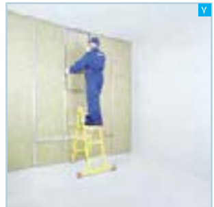
اجرای عایق پشم معدنی در فواصل بین استادها (توجه شود که تاسیسات در مرحله قبل اجرا شده است)
