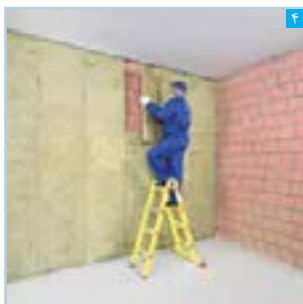
اجرای عایق پشم معدنی
