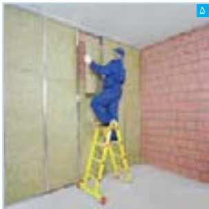
۵ اجرای عایق پشم معدنی (توجه: در فاصله میان استاداها)
