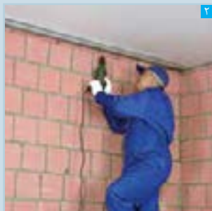
۲ نصب رانر سقف
