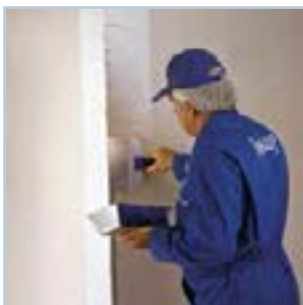
اجرای بتونه بر روی سازه محافظ گوشه
