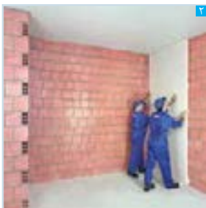
استقرار پنل بر روی دیوار زمینه
