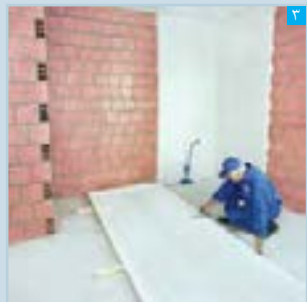
اجرای لایه فوگن فولر (به صورت شانه‌ای) بر پشت پنل مرکب ۱۰۲
