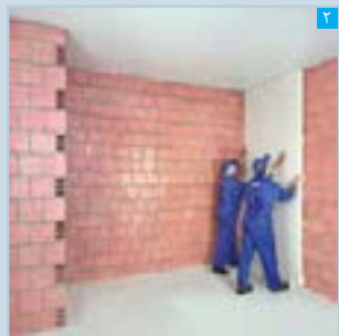
استقرار پنل بر روی دیوار زمینه
