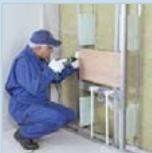
اتصال تراورس (تخته چند لایه) به قطعات نبشی L25
