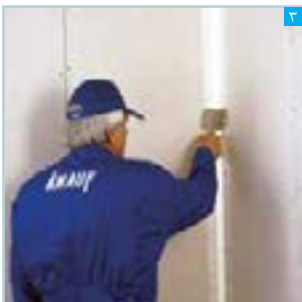
۳ تثبیت و شکل‌دهی نوار درزگیر با کاردک زاویه داخلی
