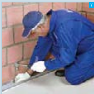
۳ نصب رانر کف
