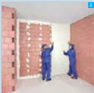
۵ استقرار پنل بر روی دیوار زمینه
