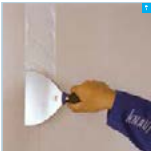
اجرای لایه بتونه در محل درز (کاردک در جهت عمود بر درز کشیده می‌شود تا بتونه در درز کاملاً نفوذ کند)
