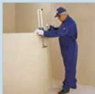
برش پنل با دستگاه برش طولی
