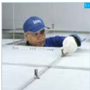
قرار دادن گیره های مخصوص نگه دارنده تایل
