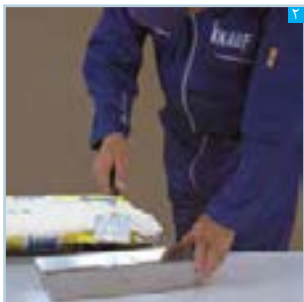
ریختن پودر بتونه در آب
