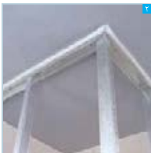
۲ شکل نوار چسب جداکننده، پس از نصب سازه‌ها
