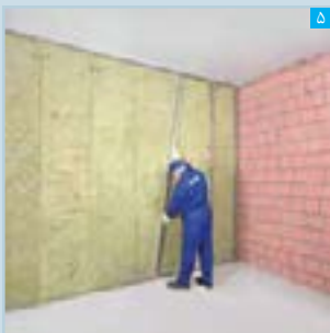
استقرار سازه‌های قائم در سازه‌های هادی و میان براکت‌ها
