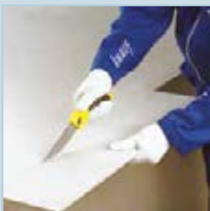
برش پنل با ااره دستی
