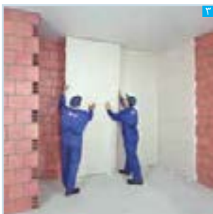
استقرار پنل بر روی دیوار زمینه
