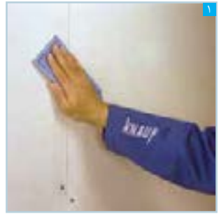
۱ تمیز کردن سطح، قبل از بتونه‌کاری و یا اجرای ماستیک بسیار مهم است.
