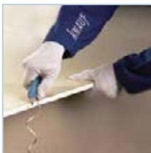
اجرای پخ با تیغ برش
