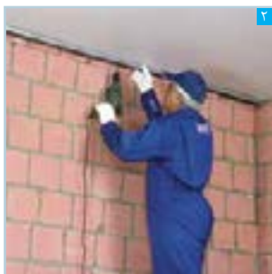
نصب سازه‌های هادی سقف و کف
