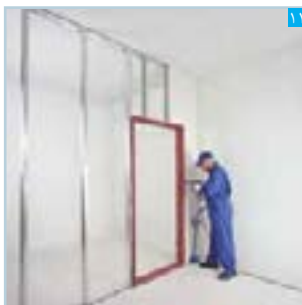
اجرای پتل اول دور چهارچوب (پتل‌ها به صورت L برش داده می‌شوند)
