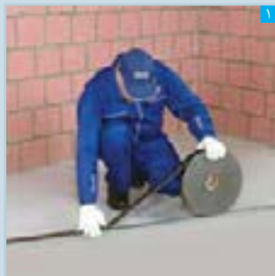
۱ اجرای نوار عایق (یا دو ردیف خمیر درزبند) در پشت جان رانر کف و سقف
