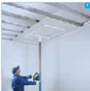
استقرار پنل با استفاده از بالابر
