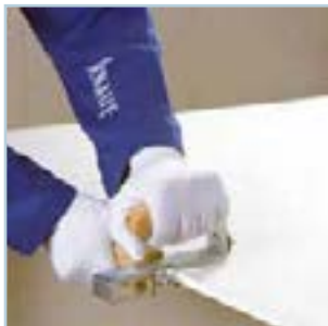
برش پنل با دستگاه برش قرقره‌ای
