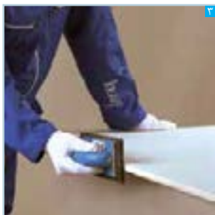
پرداخت وجه عمودی و وجه مایل لبه پیخ خورده با ساب مالهای
