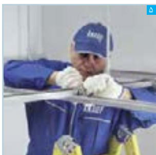
۵ اتصال سازه پنل خور به سازه باربر توسط بست اتصال
