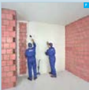
۶ تنظیم نهایی پنل نصب شده با شمشه و چکش لاستیکی
