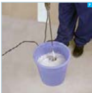
۶ مخلوط کردن خمیر به مدت ۲ تا ۳ دقیقه
