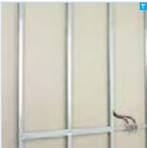
درزهای افقی به صورت حصیرچین نسبت به یکدیگر قرار می‌گیرند (به محل سازه‌های پشت بند توجه شود)
