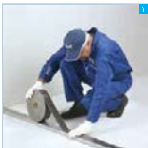
۱ اجرای نوار عایق (یا دو ردیف خمیر سیلیکون) بر پشت جان رانر کف و سقف
