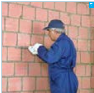
نصب براکت بر روی دیوار زمینه
