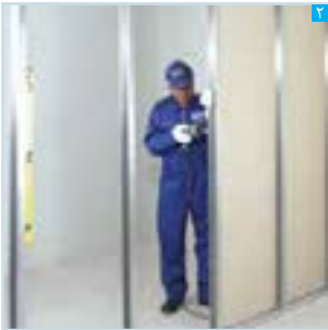
اجرای پنل‌ها در یک طرف دیوار
