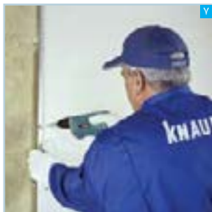
۷ توجه: پنل‌ها باید در جهتی نصب شوند که لبه آزاد آن‌ها به سمت دهانه باز استاداها قرار گیرد
