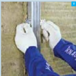
خم کردن طول اضافه بال‌های براکت (توجه: لایه عایق در پشت سازه‌ها قرار می‌گیرد)
