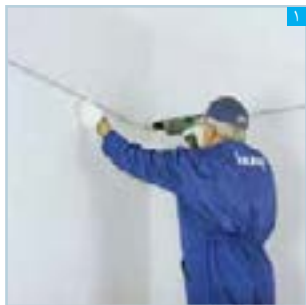
نصب سازه تراز پس از تعیین خط تراز سقف
