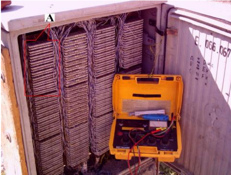
Resim 4.7: 1200'lük saha dolabının görüntüsü
