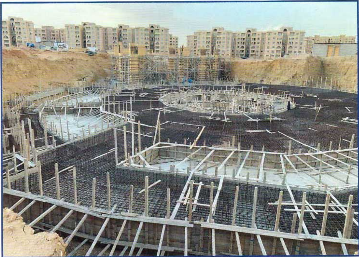
Lavori in corso dell'Orfanotrofio
